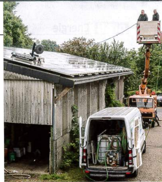
Das Solarreinigungsteam von SRS Nord ist immer zu zweit unterwegs und bringt auch einen Hubsteiger, entmineralisiertes Wasser sowie eine Pumpe mit.
